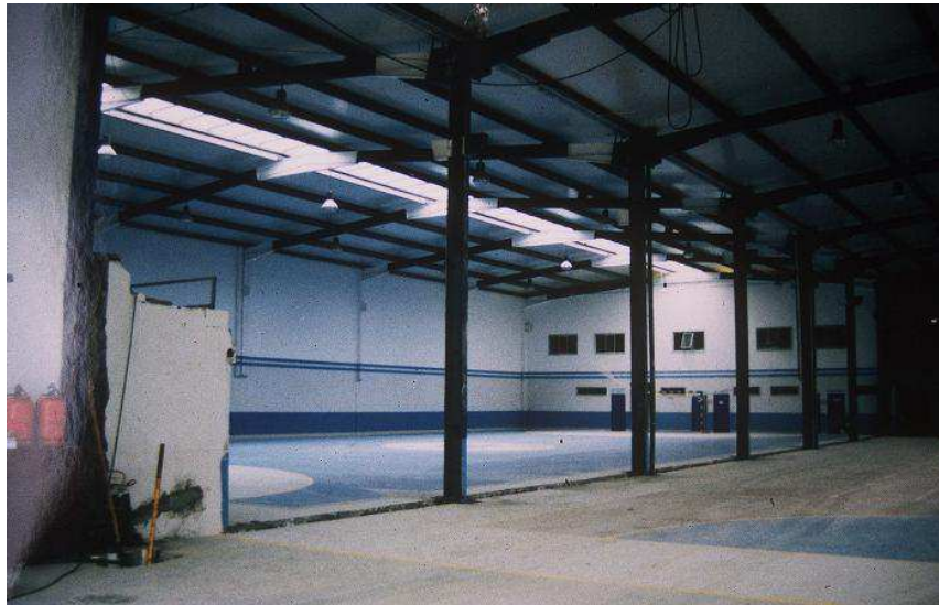
Nave sin pilares
