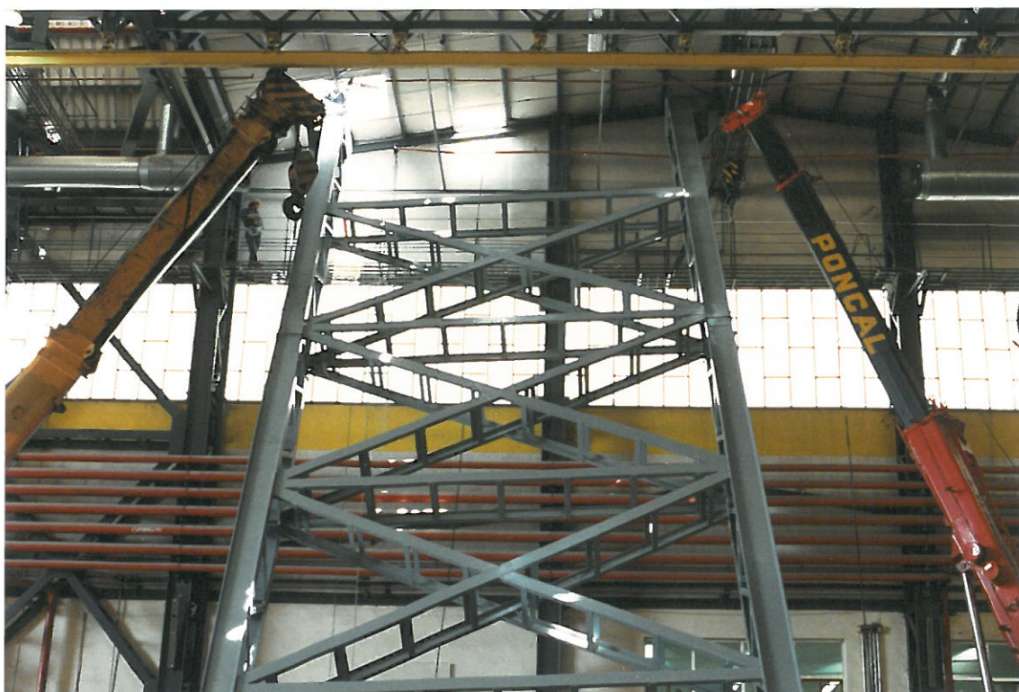
MONTAJE DE PILAR INTERIOR
