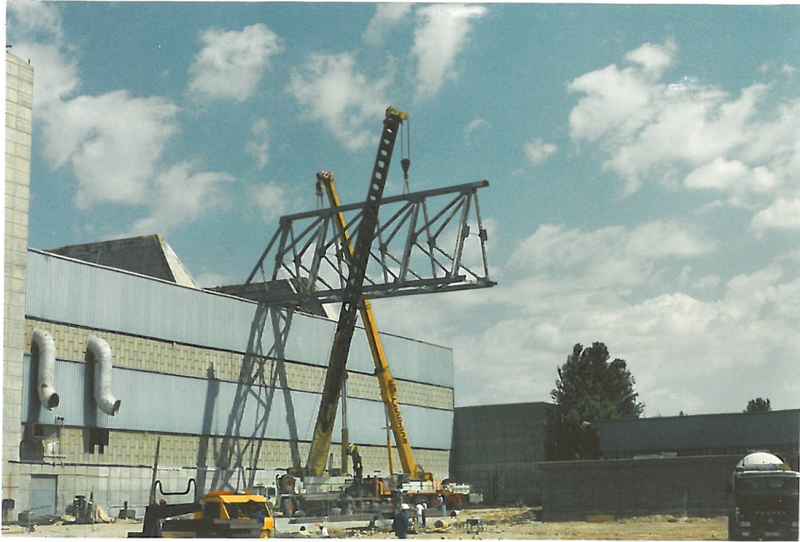
MONTAJE DEL PRIMER TRAMO DE VIGA DE CELOSIA
