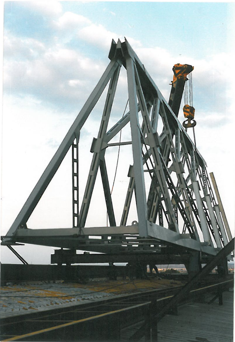
MONTAJE DEL PRIMER TRAMO DE VIGA DE CELOSIA
