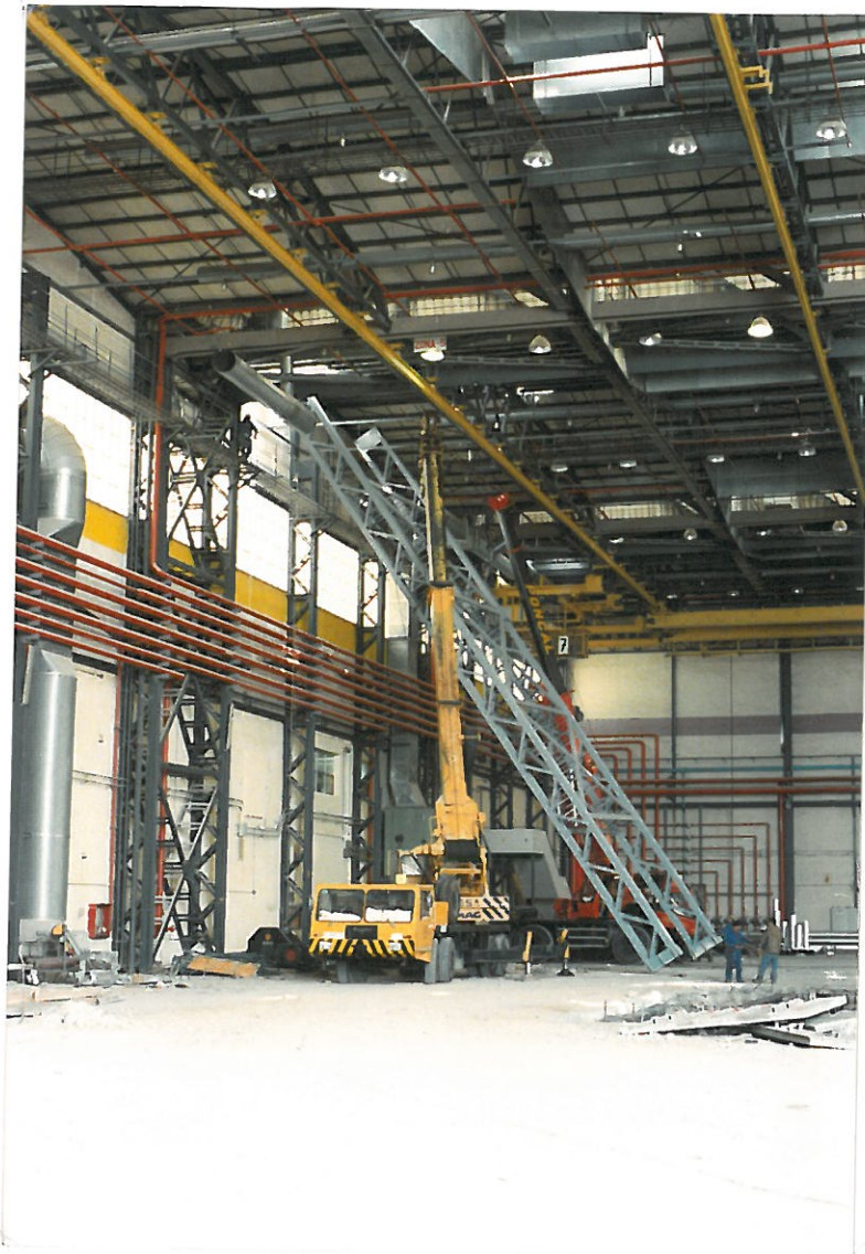
MONTAJE DE PILAR INTERIOR
