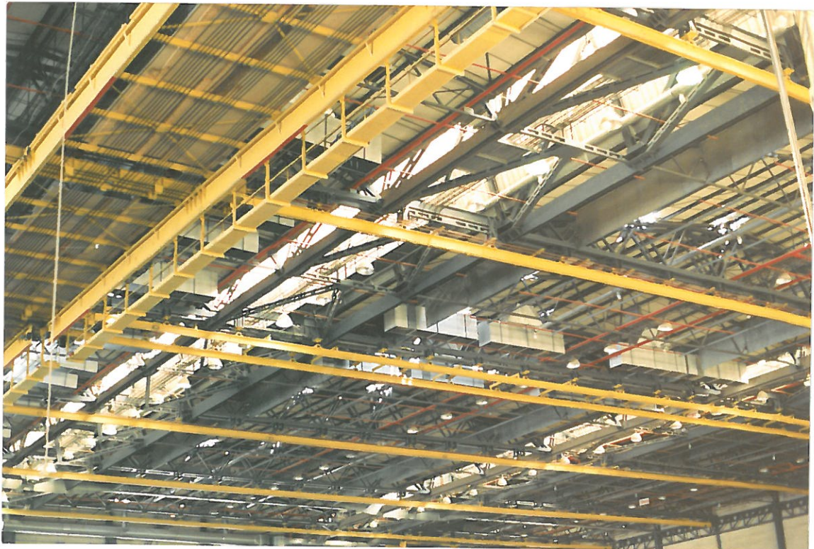
CUBIERTA DEL HANGAR EXISTENTE
